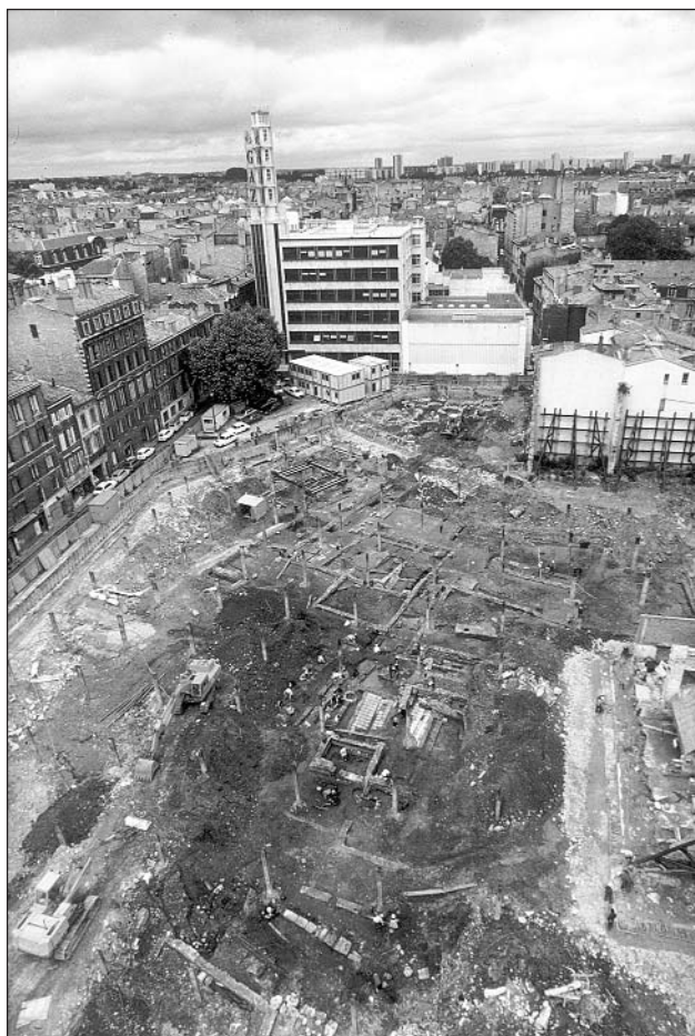
Fig. 8: Saint-Christoly. Vue general du chantier en 1982. Photo M. Gauthier. SRAA.
