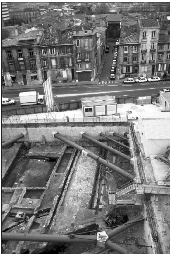
Fig. 10: Vue general du chantier de la Cité Judiciaire. Photo Ch. Sireix, INAAP.
